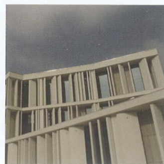
Edifici Judicial de Sant Boi de Llobregat (2007)
