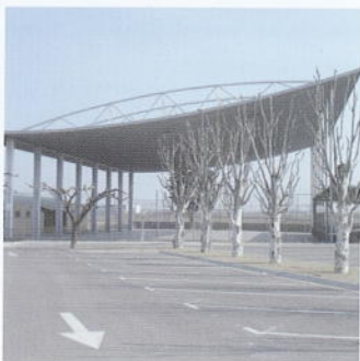
Coberta pista poliesportiva de Fondareila (Pla d'Urgell) finançada amb el PUOSC
