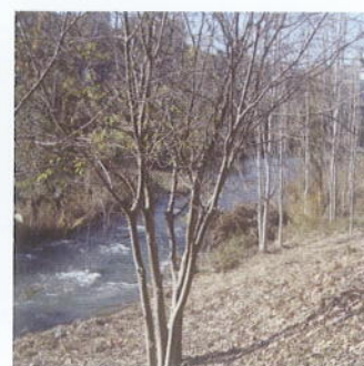
Actuació de millora de les lleres a Manresa (2010)
