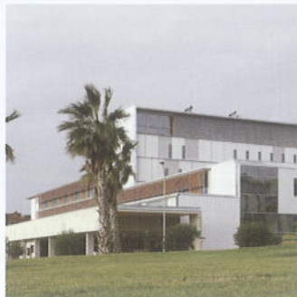
Nou Hospital Moisès Broggi de Sant Joan Despí (2010)
