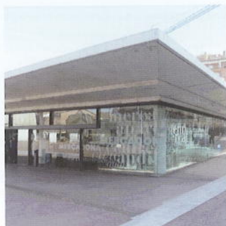
Renovació del mercat municipal de Castellà del Vallès (2008)
