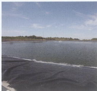
Modernització del regadiu Garrigues Sud (2010)
