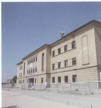
Obres de la nova seu del DAR a Gardiny (2010)
