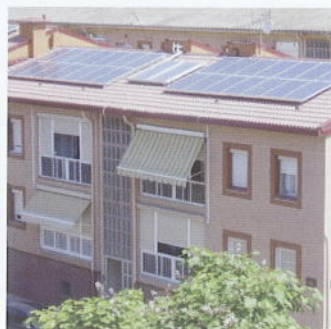
Instal·lació de plaques solars i rehabilitació d'edificis al barri de Pomar de Badalona
