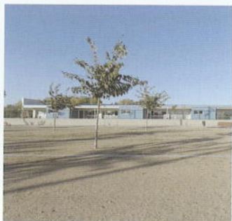
Construcció de l'Escola Balaguer a Balaguer (2008)
