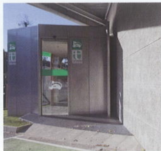
Punt de càrrega de vehicles elèctrics
