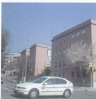
Rehabilitació de façanes al barri de Verdum de Barcelona (2006)
