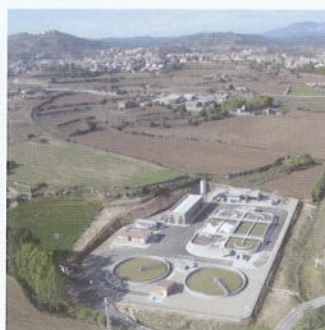
Nova depuradora de Solsona (2009)
