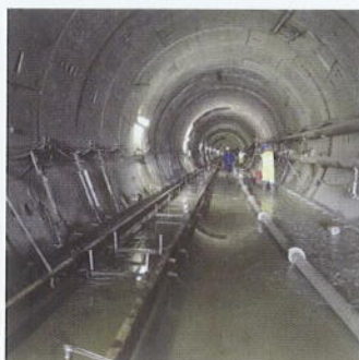
Galeria de la connexió Font Santa-Trinitat a Horta (2008)
