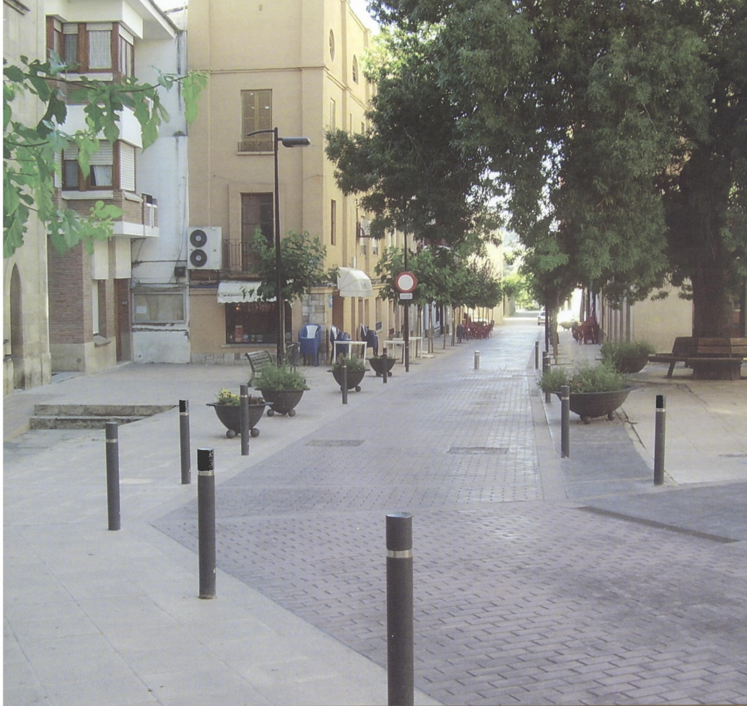
Obres de pavimentació del nucli urbà de Flix, a la Ribera d'Ebre
