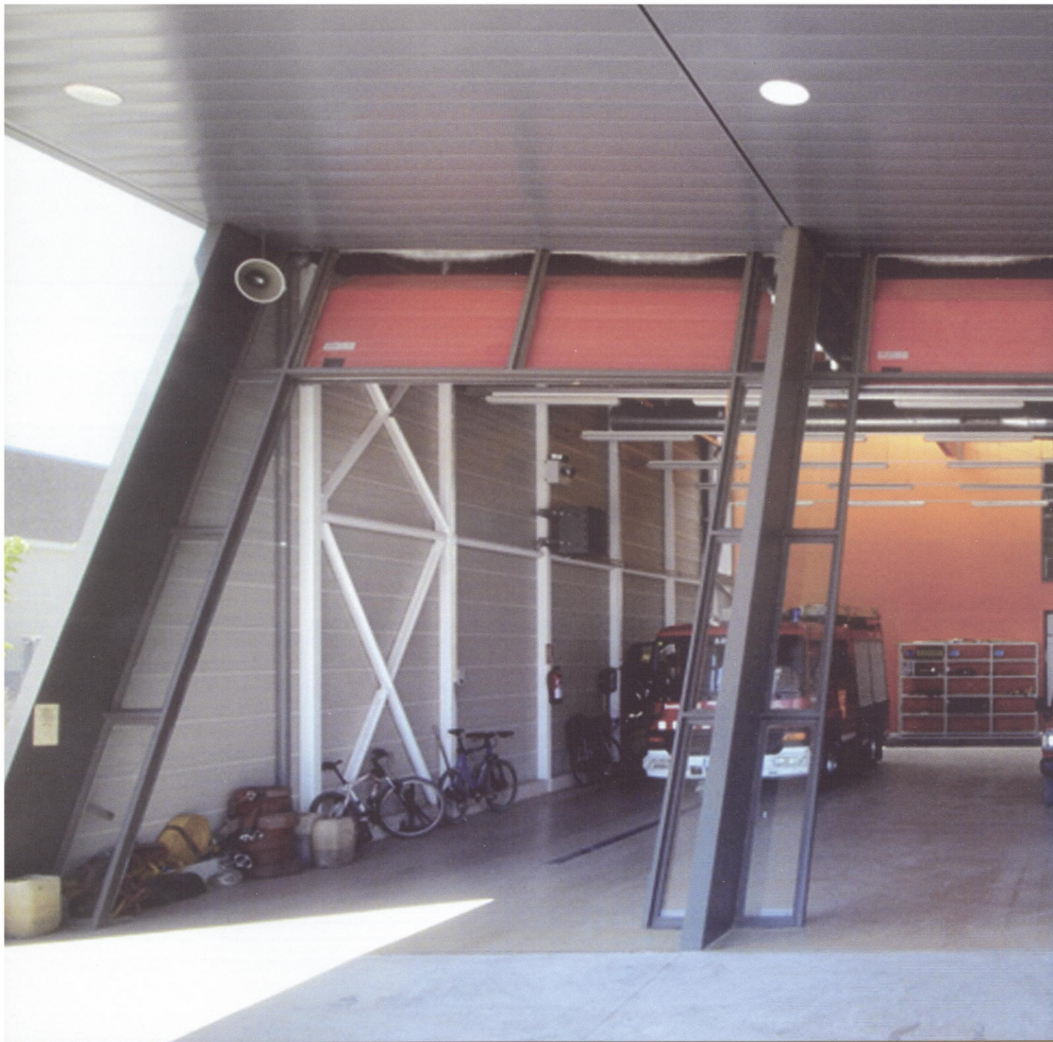
Parc de bombers de les Borges Blanques (les Garrigues)
