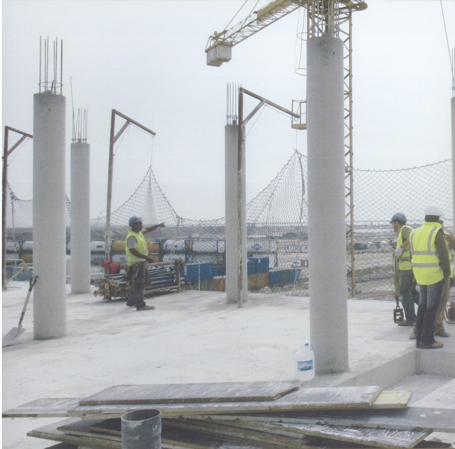
Treballadors equipats amb casc i armlles fluorescents. La prevenció és fonamental en la lluita contra els accidents laborals
