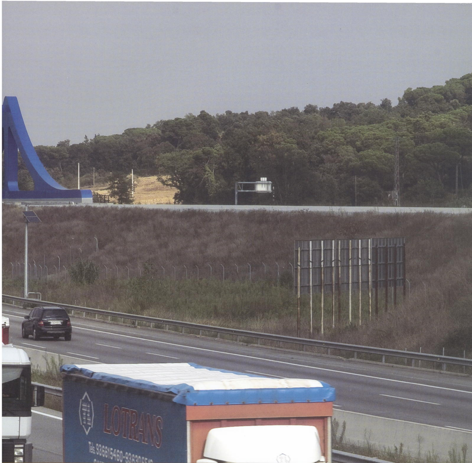
Pont de la via del TGV per sobre de l'autopista AP-7, al Vallès Oriental
