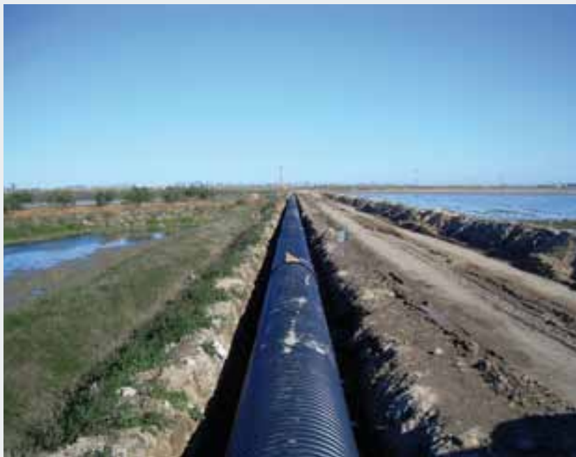
Instal·lació d'una canonada de reg
