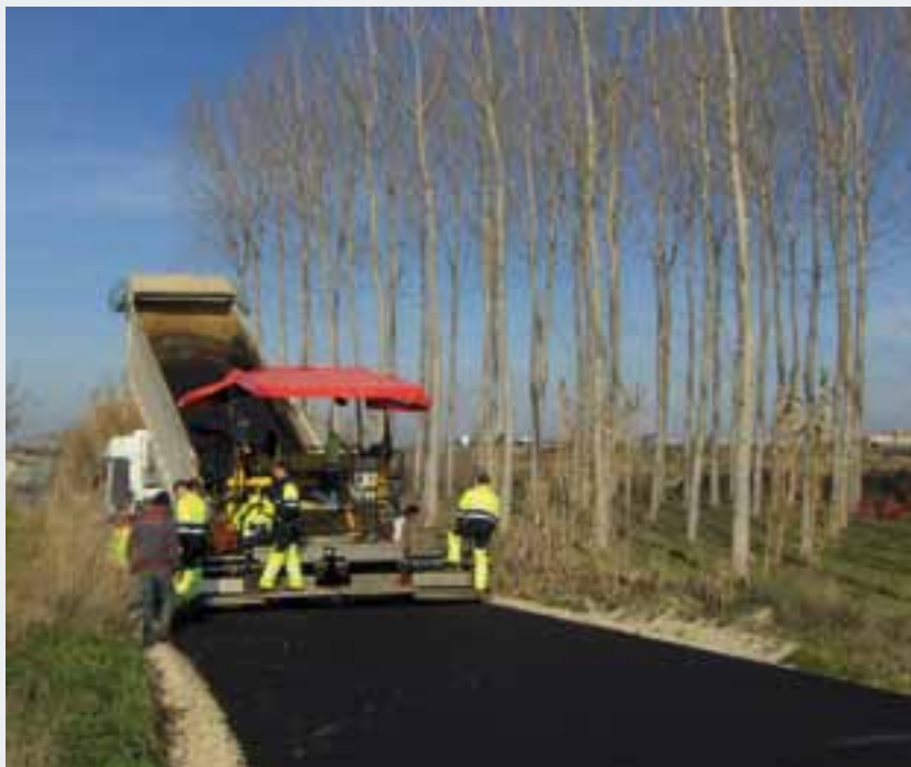
Obres al camí de l'Esrany d'Ivars
